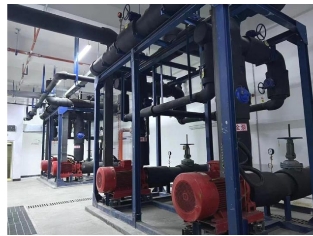
项目现场完成模块装配
