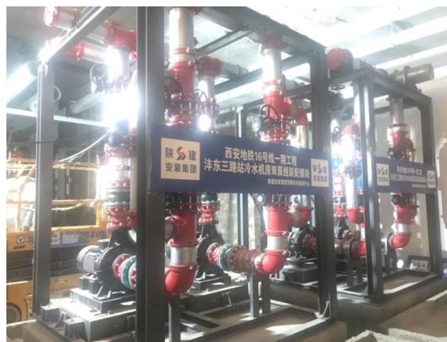
地铁16号线一期工程冷水机房整体装配式施工
