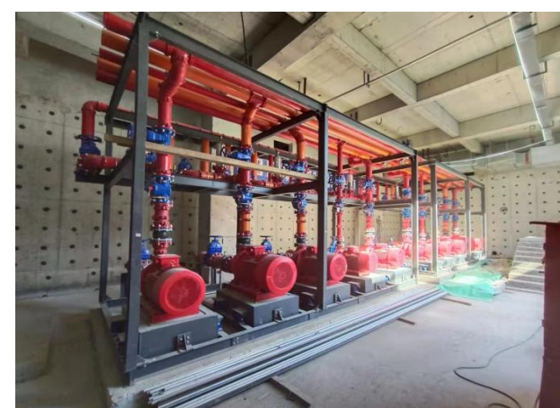
项目现场完成模块装配
