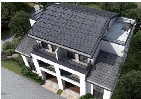
太阳能光伏坡屋面示意图
